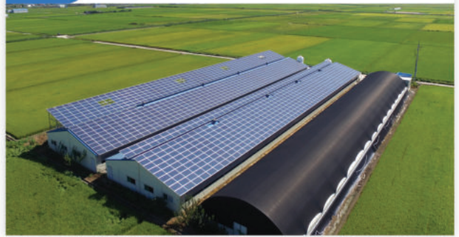
350kW 전북 익산시 신흥동 903-5번지 (오리)
