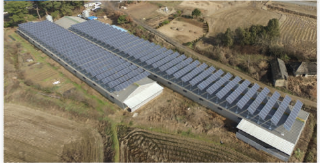
175kW 전북 익산시 망성면 어량리 652번지 (육계)
